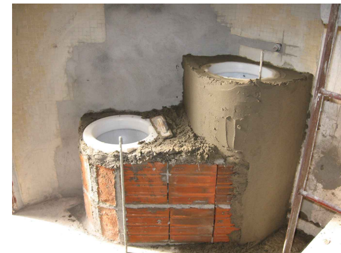
IMAGEN ILUSTRATIVA PACK SANITARIO EN ROTOMOLDEADO CAJÓN LLENO Y COMIENZO DE REVOQUE
